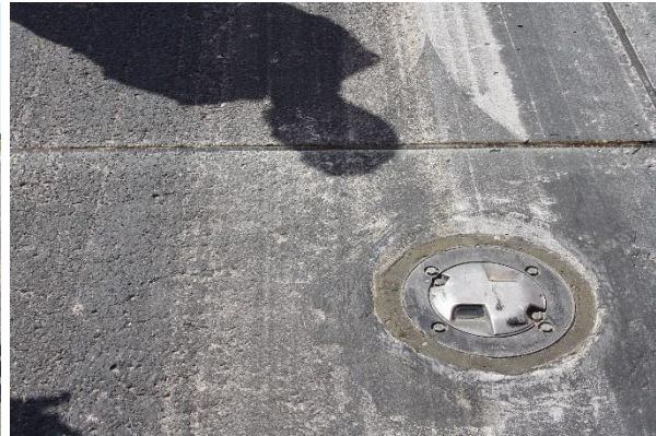
Rollbahnbeleuchtung auf dem Taxiway
