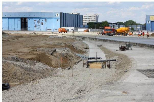
Drainage und Leerrohre werden mitverlegt
