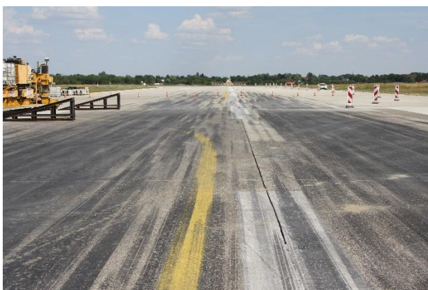
Touchdownzone mit Gummiabrieb
